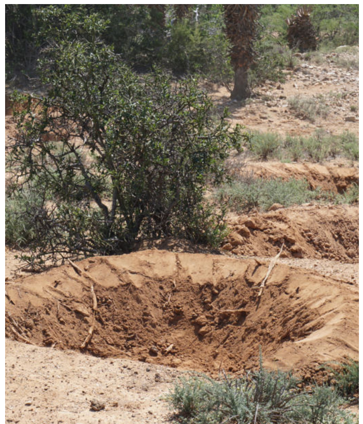
Halbrunde Wasserrückhaltelöcher sollen zusätzlich den Wasserabfluss verringern. Gegraben werden diese von Hand.
